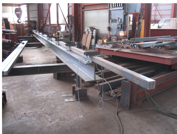
写真-16 治具で固定された角鋼
