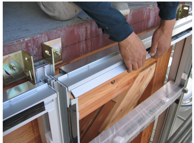
写真-23 ファサードのサッシュ取付
