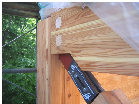
写真-17 ブレース端部現場溶接後
