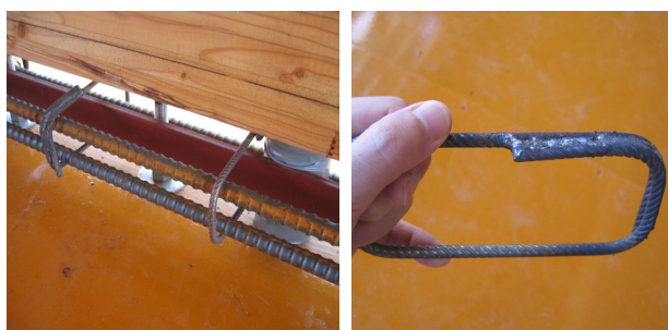
写真-20 スラブ補強の梁と D6 スタラップ
