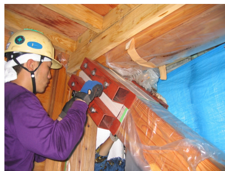
写真-18 ボルト軸力で接着面の圧力管理を行う
