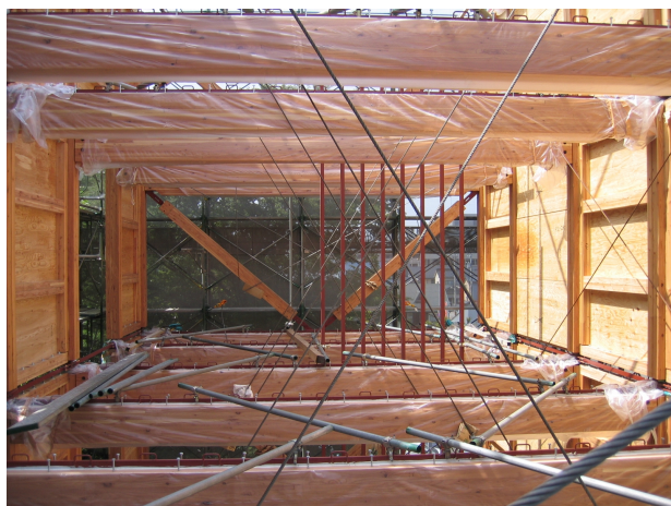
写真-14 仮設ブレース
