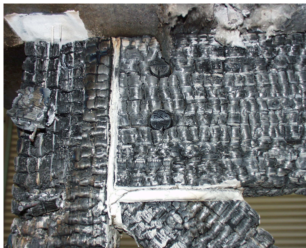
写真-8 ガセット接合部のHTBの埋木が機能している
