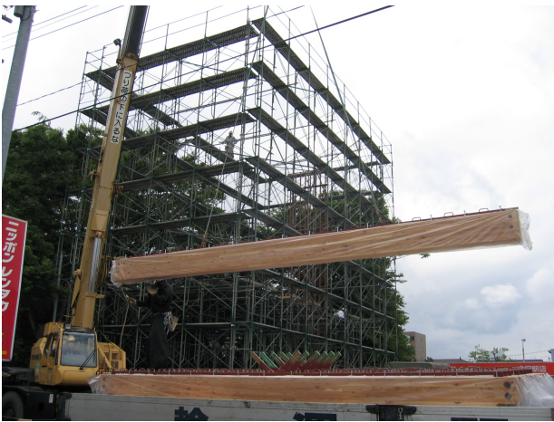
写真-12 複合部材の梁はビニルシートで養生されている
