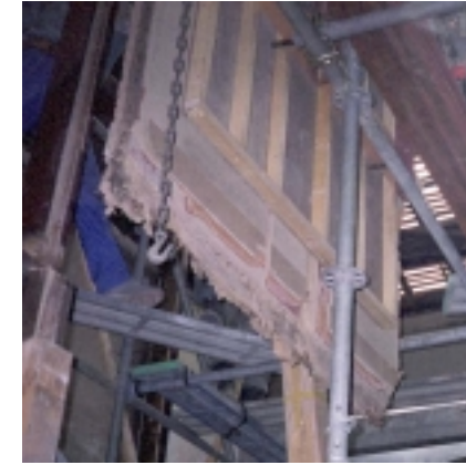
階段上の壁は中でも最も古く、周りの柱・梁はシロアリがついてぼろぼろだったので取り替えざるを得なかった。改修にあたって壁を両側から合板でサンドイッチにしてボルトで留め、上から吊り下げつつ骨組を替える「おおばらし」という工法を使っている。柱・梁を取り替えてからもう一度壁を固定するこの工法は、「桂離宮」などの改修でも行われるやり方である。
