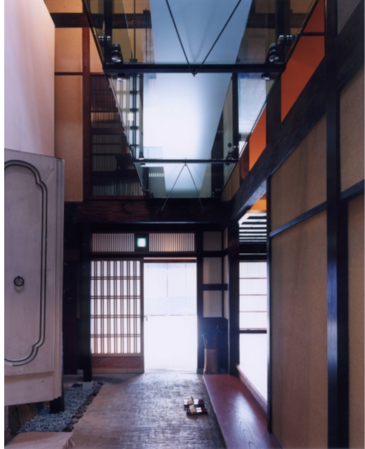
玄関を振り返る 左側が『お蔵』・上がガラスブリッジ 1階の壁は『切り返し(中塗)』
