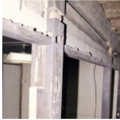
梁と水切板の名残り跡に後世、鴨居が取り付けられている
