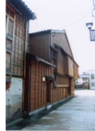
西側 北西方向より
