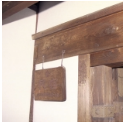
「旧諸江屋」の右2軒隣の民宿「陽月」。大戸が取り付けく梁の上には水切が付いている
