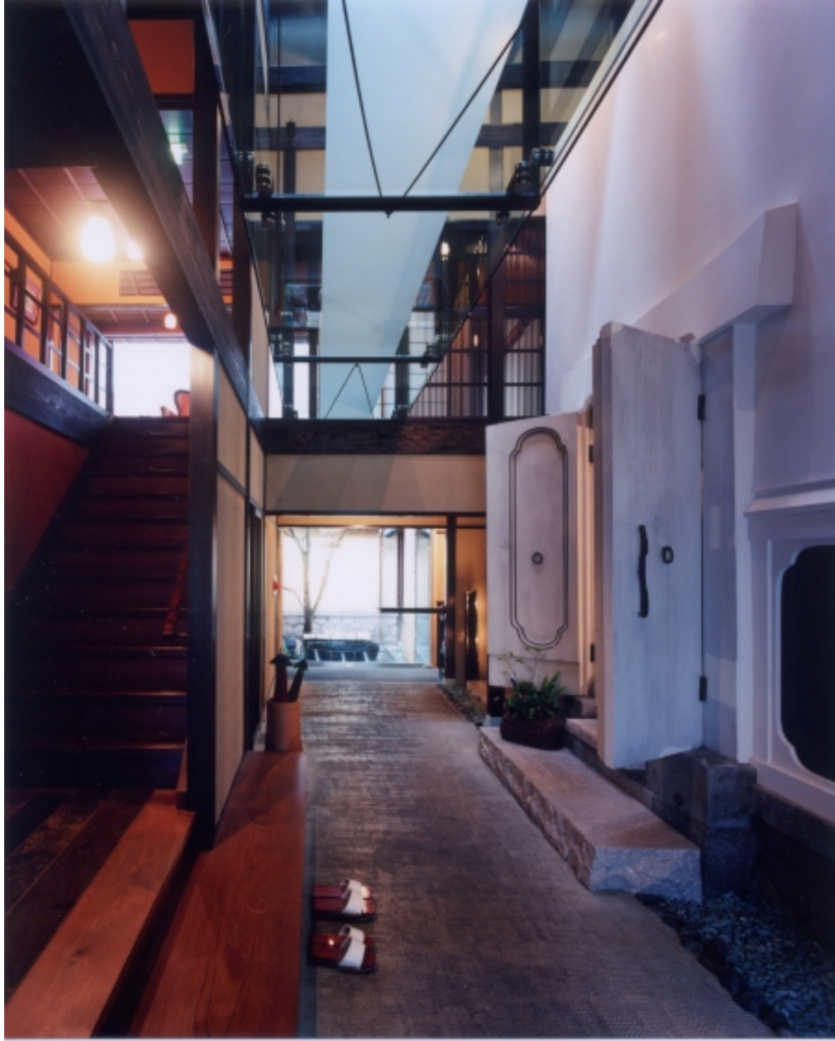
玄関に入って正面方向を見る 左が階段・右が『お蔵』 床仕上げは床暖房された三和土の土間
