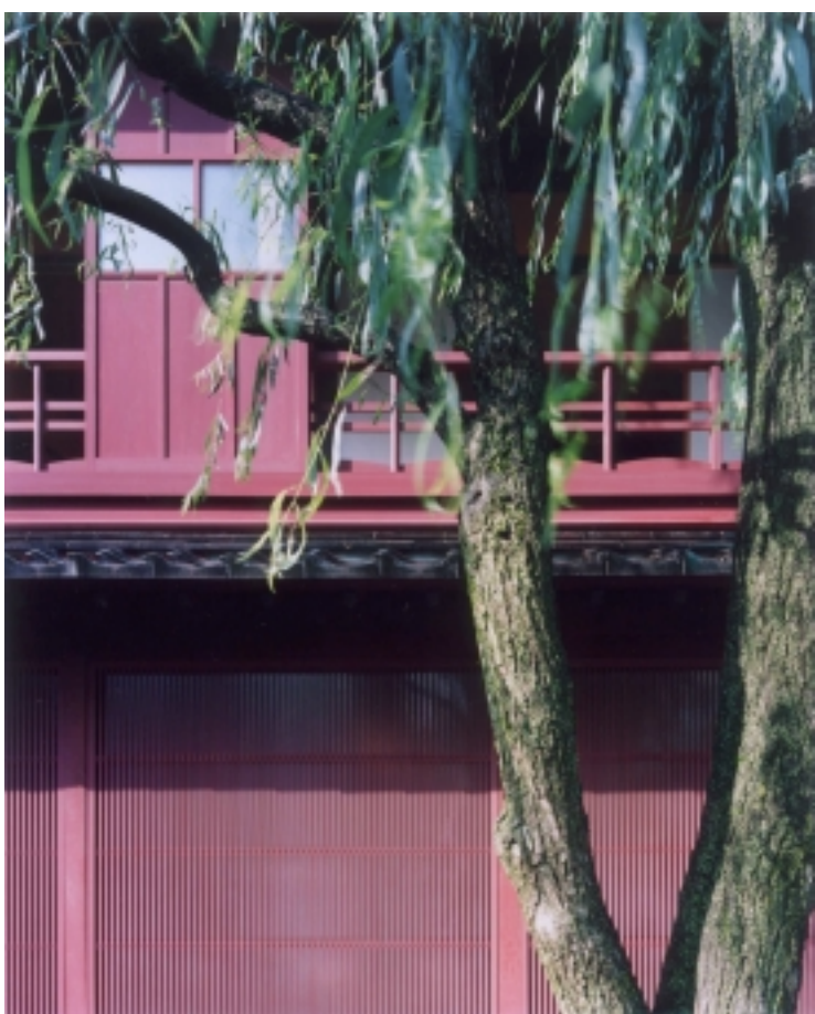
再現された二階縁側の手摺
