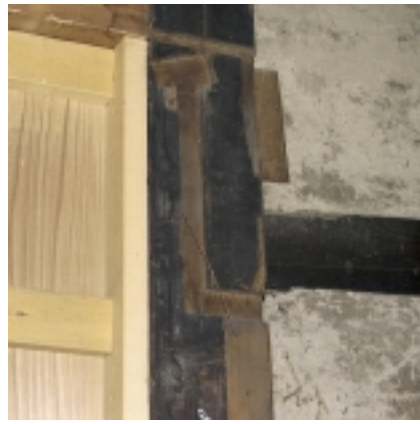
かつて梁が取り付け、その上に水切板があったことがわかる大戸の西側柱
