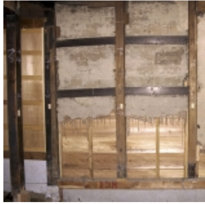
「吉文字や」であった頃の玄関。左側二本の柱間に大戸が取り付けしていた
