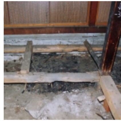
木虫籠の内側(「店の間」の縁)の縁側板を開けると、下には炭置場があった
