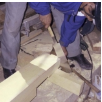
新しく根継ぎされる部材の加工(ヒバ)
