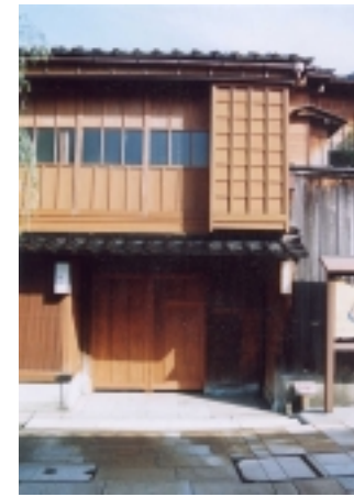
南側玄関周り
