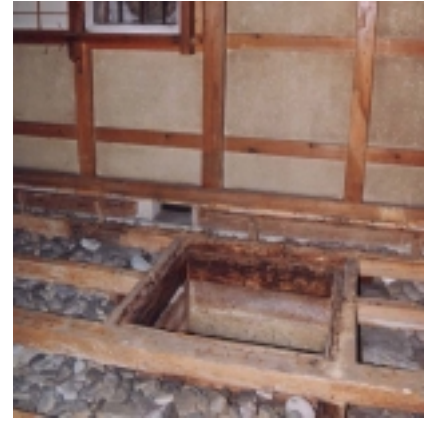
土蔵の床板を剥がした状態。ぎっしり石が敷き詰められ、小さなムロがあった
