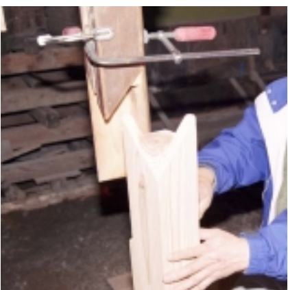
1階「白糸」の面皮柱(杉)の仕口。面皮の場合、一本一本様子が違うので、角を避けて斜めに継ぐ「箱継ぎ」と「いすか継ぎ」を併用して継手を目立たないようにする
