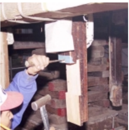
根継ぎされる柱。金輪継手(かなわつぎて)の現場加工
