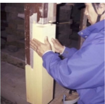
丁寧に何度も摺り合わせて、既存の柱との目違いをなくす
