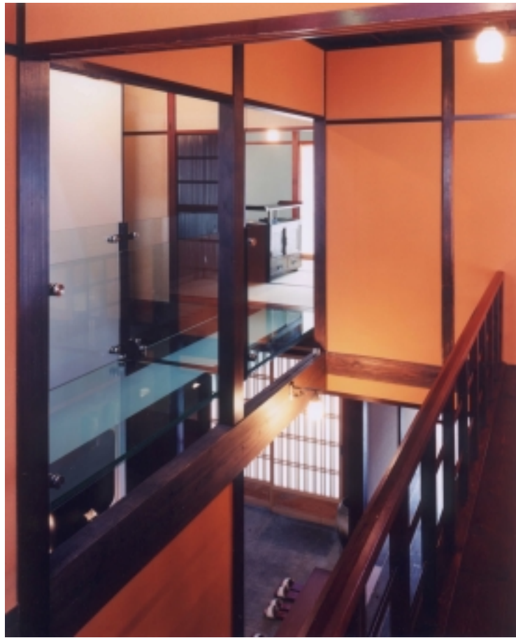
二階の照柿色の壁(のっぺりする色なので多めの水分量で塗り、一気に乾燥させることで壁表面に細かなひび割れを起こさせてざらざらなテクスチャを与えている)
