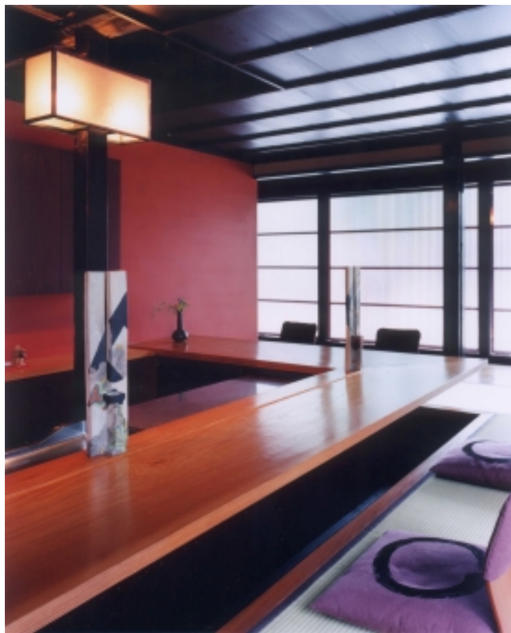
カウンター席の赤大津壁(紅漆喰を塗ることで耐震壁の直面を目立たなくしている)
