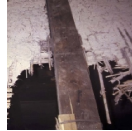
普通、土壁の下地は竹を細かく割った「竹木舞(たけこまい)」で組まれることが多いが、ここでは葦で木舞が組まれていた。
